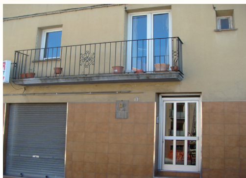
Foto 2011. Estat actual de la casa on la tradició diu que va néixer Lliberada.
